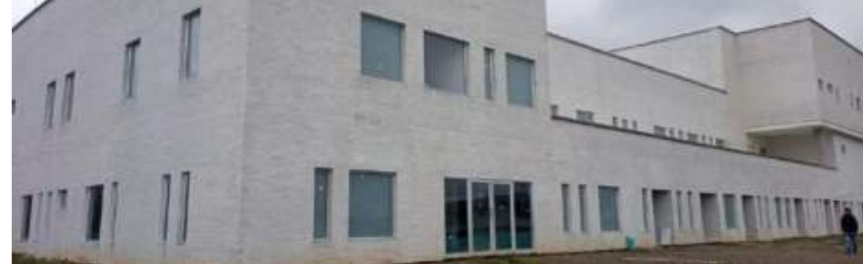
HOSPITAL EN CONTRUCCIÓN LA UNIÓN
